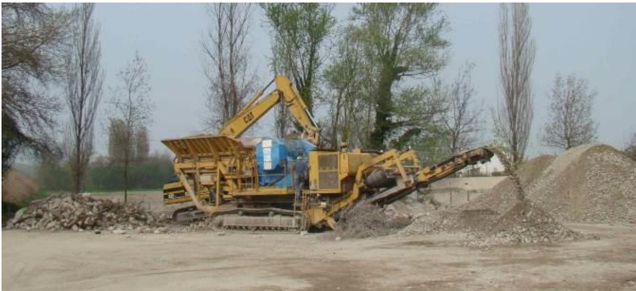
Attività di recupero con frantoio mobile in nolo a caldo
